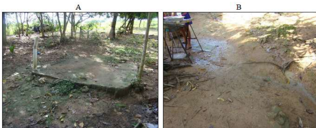
Figura 30 – Fossa negra (A) e lançamento de esgoto in natura (B).
