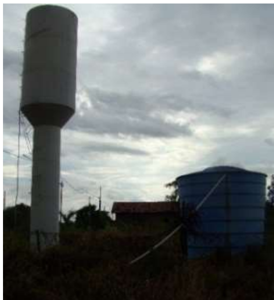
Figura 14 - Reservatório tipo taça de 5m 3 e reservatório de 20m 3 no assentamento Serra Azul.
