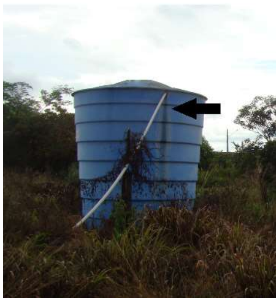
Figura 13 - Reservatório de fibra de vidro de 20m 3 com vazamentos indicado pela seta.
